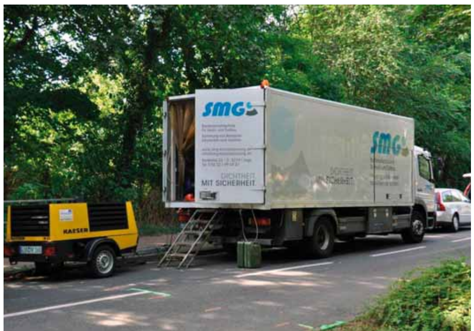
Oberflächlich eher unspektakulär: Die Baustelle am Schwichowwall aus der Perspektive der Verkehrsteilnehmer.
