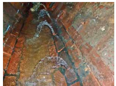
An den Bohrungen für die Injektionslanzen zeigte sich deutlich, welcher Grundwasserdruck auf dem Sammler am Schwichowwall lastet.
