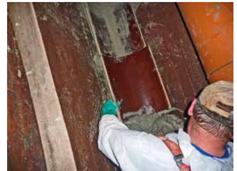
Verlegung eines Steinzeug-Gerinnes in dem begradigten Unterbogen des Bauwerks.
