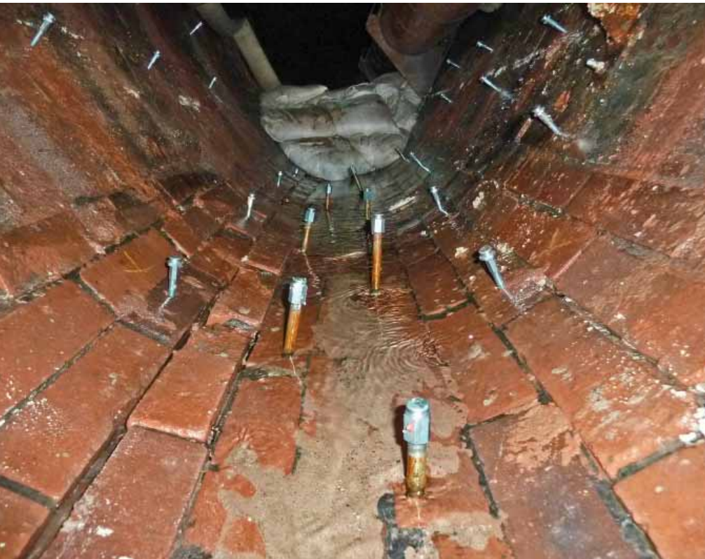
Mit diesen Bohrpäckern wurde Material zur Abdichtung und Stabilisierung unmittelbar in die Wand des marmorierten Bauwerks verpresst.
