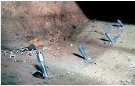
Injektionspacker in der Sohle des Tunnels im Übergangsbereich zum Schachtbauwerk.
