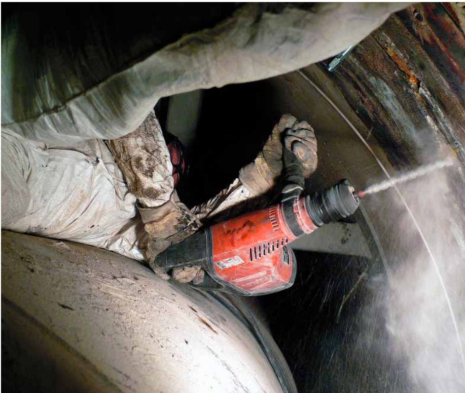
Harte Arbeit bei mehr als 40°C: Die 25 Zentimeter starken Stahlbetonrohre der Tunnel werden mit Bohrern perforiert, um anschließend Injektionspacker in die Bohrungen zu setzen.
