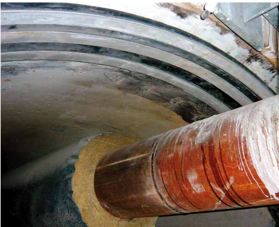
Der Endzustand: Der durch Injektion abgedichtete Übergangsbereich von Tunnel und Schacht mit einer AMEX 10-Manschette als Sekundärdichtung.
