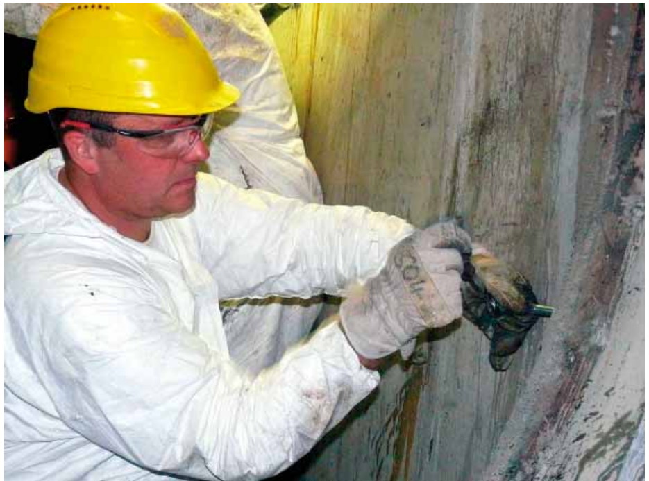
Ein Injektionspacker wird in ein Bohrloch geschraubt.
