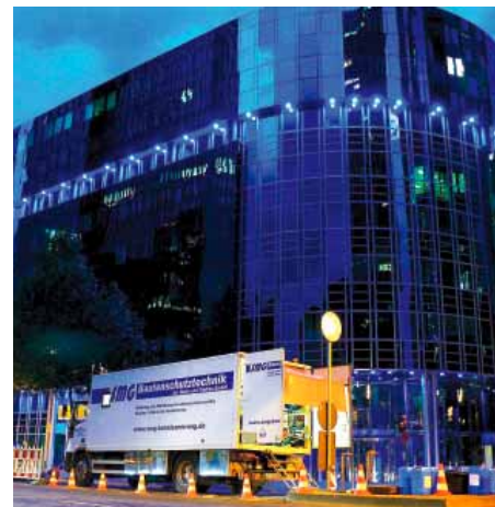
Nachtschicht im Fernwärmehöhle: Das SMG-Einsatzfahrzeug auf einer abgesperrten Fahrspur vor der Kulisse des Frankfurter Bankenviertels.
