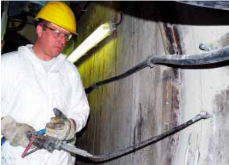
Verpressen des Injektionsgels über Druckschlauch und Packer.
