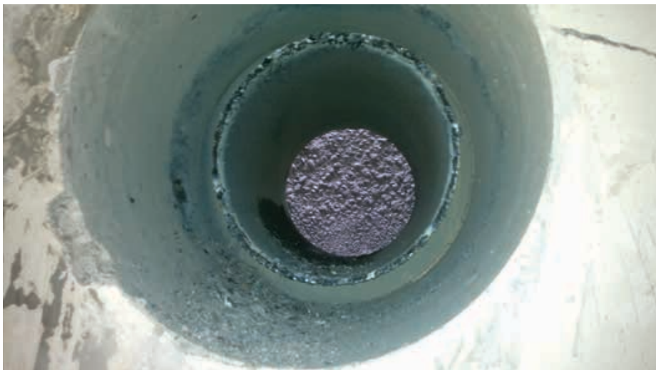
Ein Blick durch Kernbohrung und konische Stahldurchführung nach Überbohrung der korrodierten Stahldurchführungen durch Stahlbetonwand zum Ablaufbauwerk.
