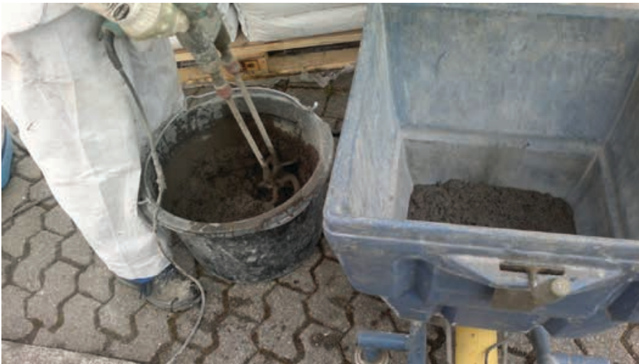
Das A und O gelungener Betoninstandsetzung: Schulung, Sorgfalt und Erfahrung, hier zum richtigen Anmischen der Mörtelkomponenten.
