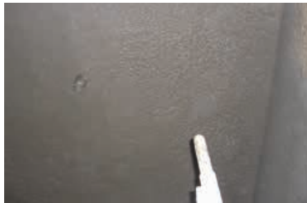
Bei den Deckenflächen des Einlaufbauwerks waren Spritzarbeiten über Kopf erforderlich.
