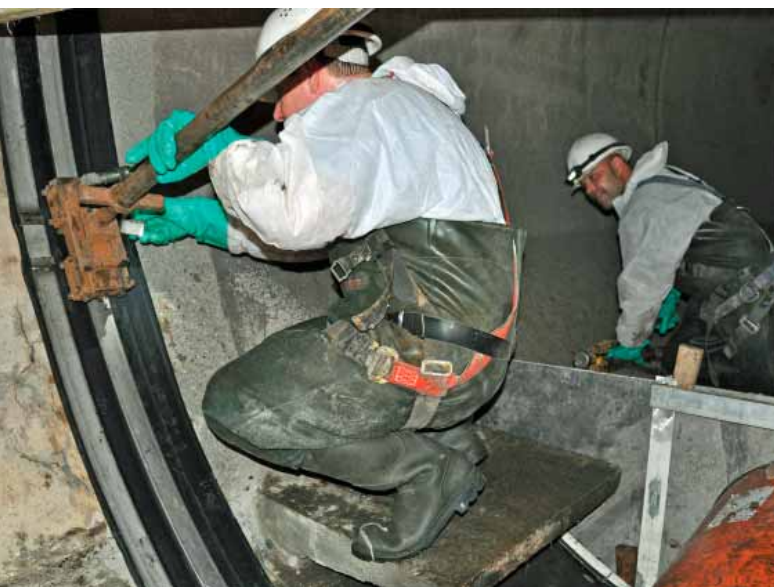
Verspannen der Stahlbänder auf der unterliegenden Gummimanschette mit Hilfe der patentierten Amex-Schlosskonstruktion.
