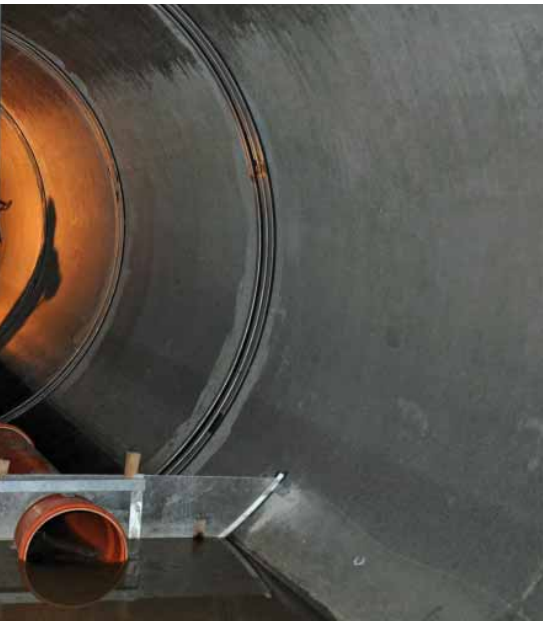
Die fertige Bypass-Konstruktion. Der Arbeitsbereich zwischen den Schotts ist bereits trocken gelegt.
