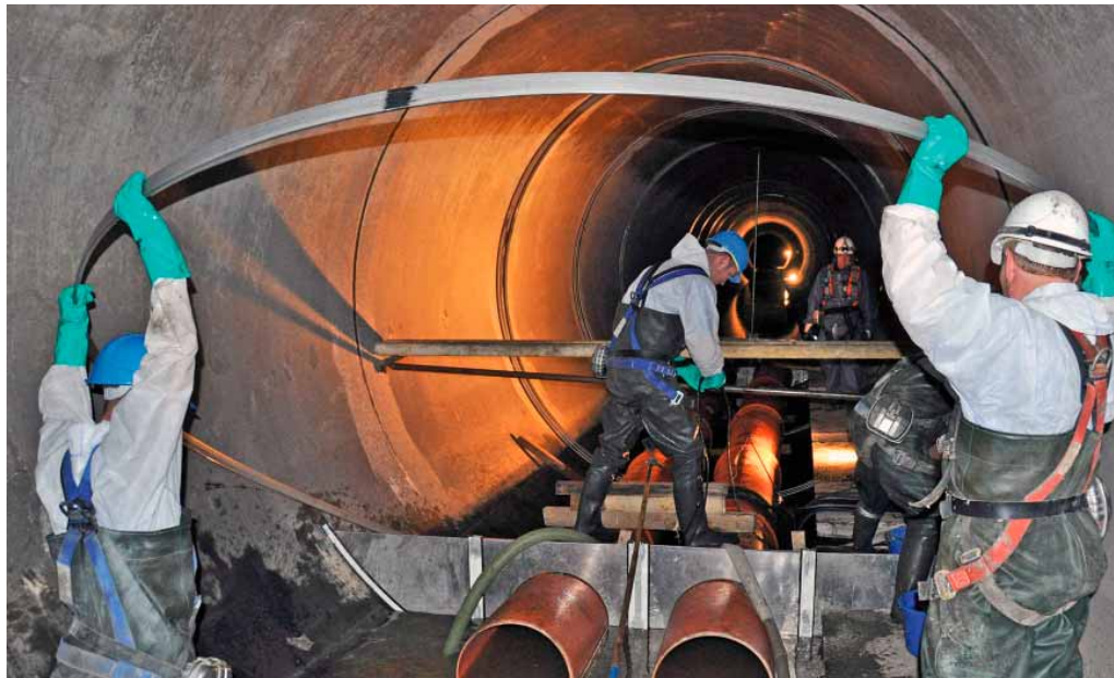
Stahlband der Amex-Manschette unmittelbar vor der Montage. Die Dimension DN 3800 markiert für das Verfahren den derzeitigen Europa-Rekord.
