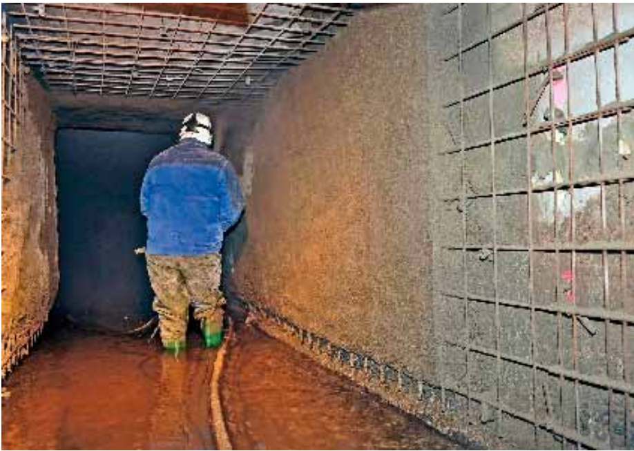
In Trockenspritztechnik wurde um die Armierungen eine 10 Zentimeter starke Spritzbeton-Schicht aufgetragen.
