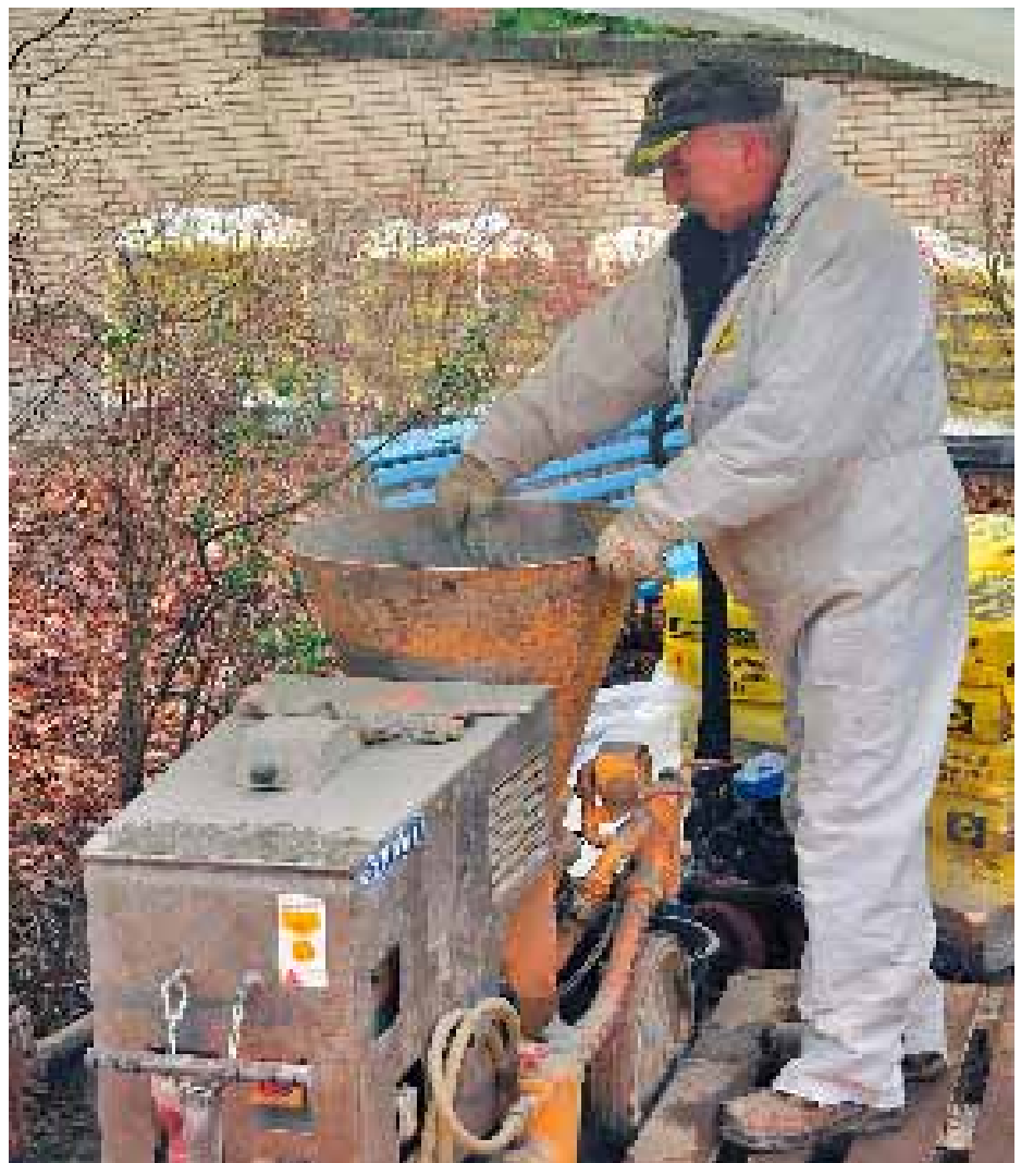
Vorbereitung des Spritzbetons oberhalb des Eingangs zum Hartmann-Kanal.
