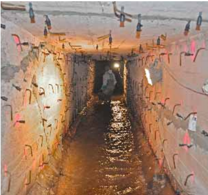
Das Bauwerk, gespickt mit Injektionspackern: Durch Verpressung von insgesamt 150 m 3 Spezialzement wurden Hohlräume im Umfeld des Bauwerks verfüllt und die Standsicherheit der darüber liegenden Verkehrskreuzung wieder hergestellt.
