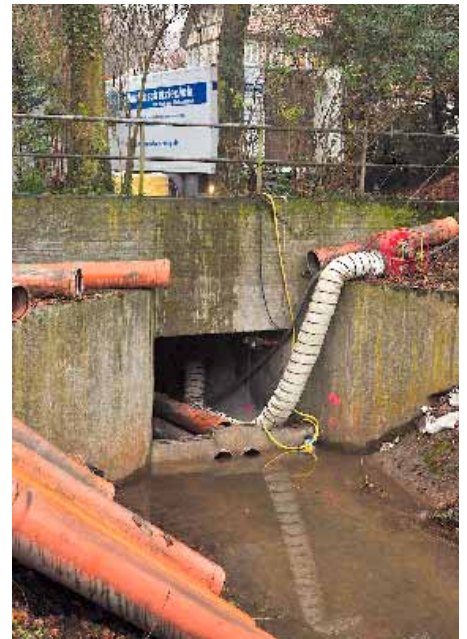
Zugang in den Hartmann-Kanal mit Baustellenaufbau.
